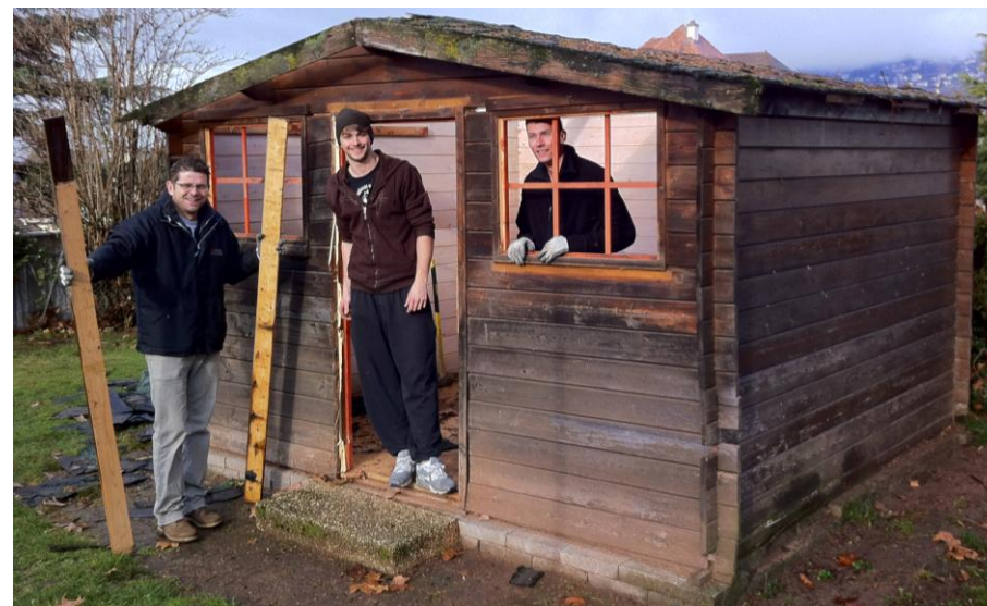
Photo 1 : Démolition du cabanon le 28.01.2012 avec John Linder, Yves Bongard, Dominique Charpiloz, Laurent Soldini et Marc Soldini.
